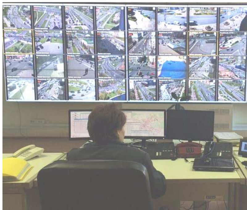
Рисунок 10. – Зал управления программно-технического комплекса центрального управляющего пункта автоматизированной системы управления дорожным движением с системой видеонаблюдения
