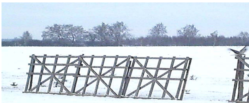
Рис. 8.15. Установка решетчатых щитов с разрывом
