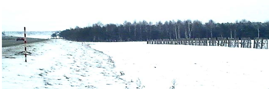
Рис. 8.13. Установка решетчатых щитов
