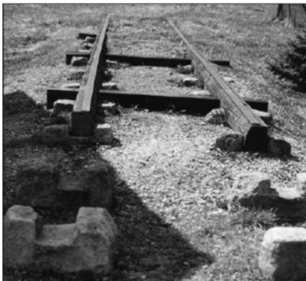
*Рис. 3. Укрепленные поверх деревянных лежней чугунные пластины – прообраз современных стальных рельс (фото из [41])*
