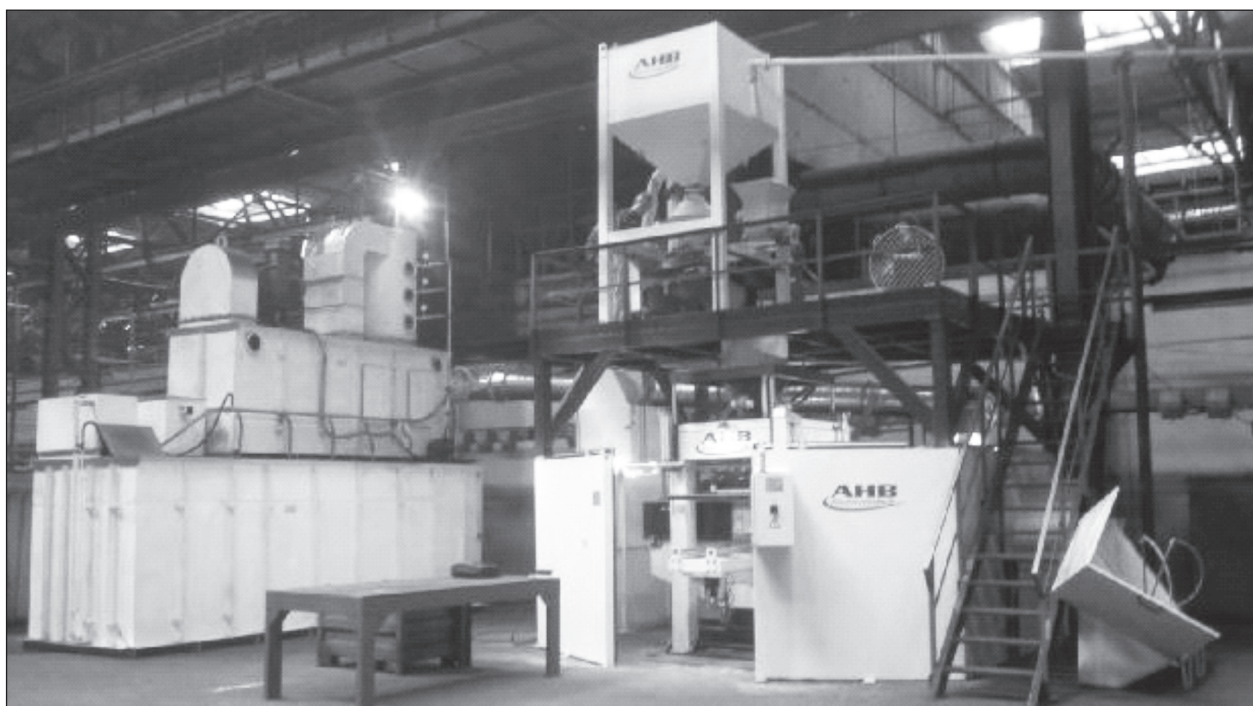
Общий вид размещения стержневого оборудования на площадке ОЛП РУП «Гомельский завод литья и нормалей»: слева – абсорбционно-биохимическая установка, справа – стержневой автомат мод. АНВ-40НV с установкой смешеприготовления
