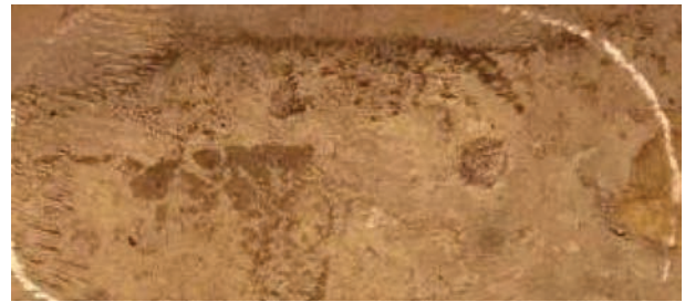
Рис. 3. Внешний вид дефектов
