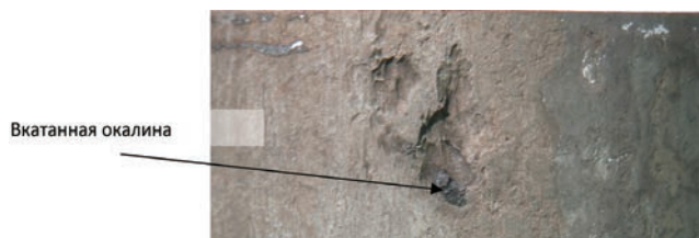
Рис. 1. Внешний вид отпечатков от вкатанной окалины на наружной поверхности горячекатаной трубы
