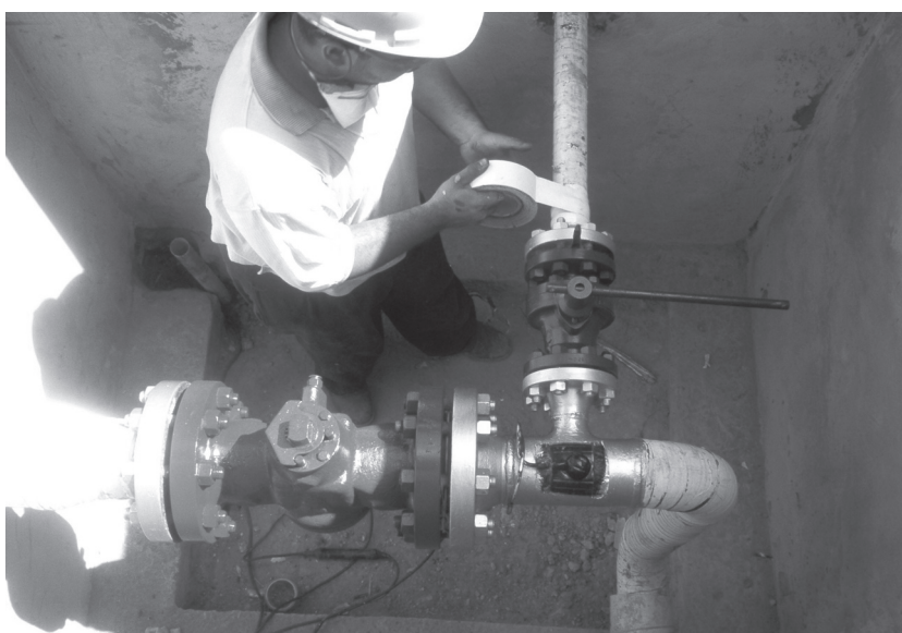
Работа в газовом колодце
