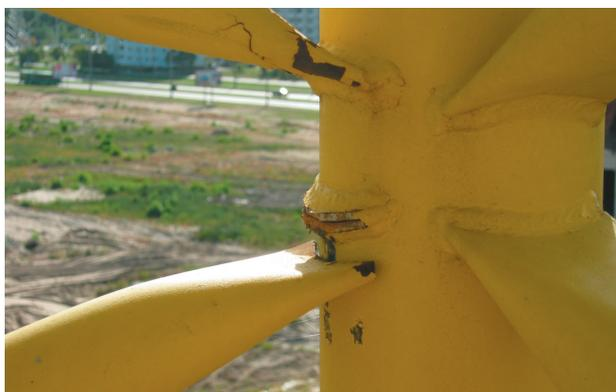
Рис. 4. Разрушение сварного соединения
