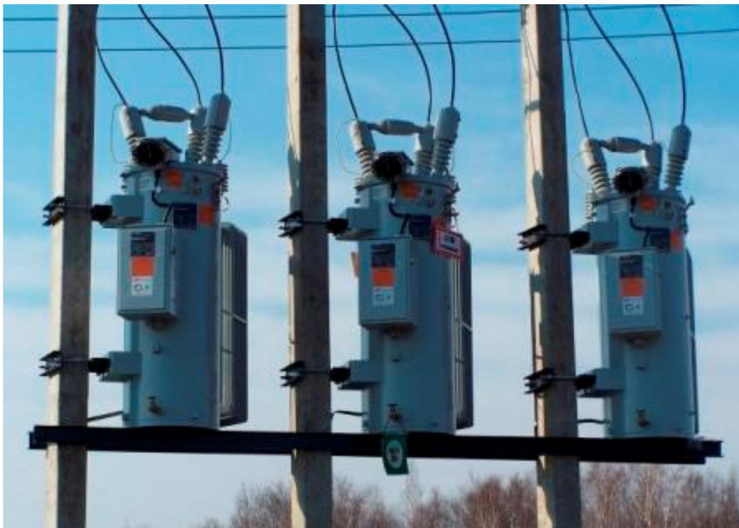
Рисунок 3 – Пункт автоматического регулирования напряжения типа ПАРН-ВДТ-СН
