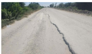
Рисунок 2 – Примеры разрушения покрытия
