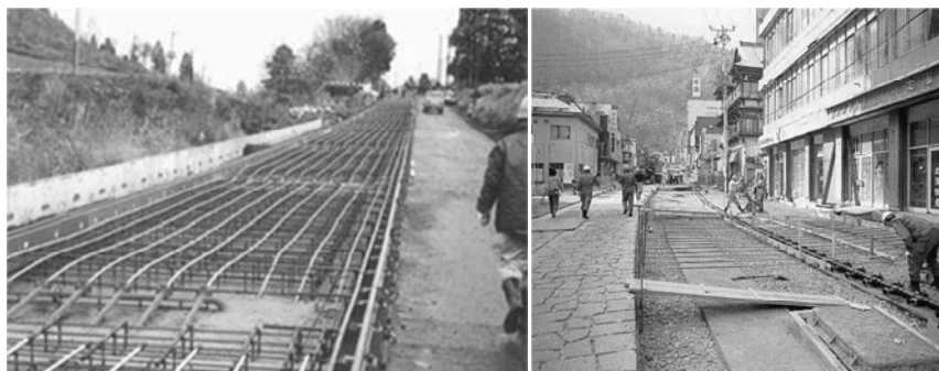
Рис. 9.2. Прокладка тепловых труб под дорожным полотном
