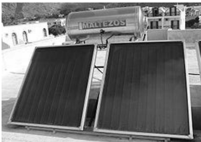
Рис. 3.1. Внешний вид плоского солнечного коллектора
