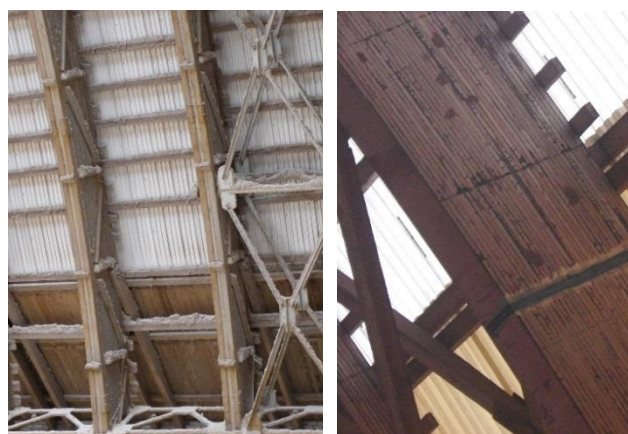
Рисунок 1 – Способы усиления деревянных арочных конструкций:
