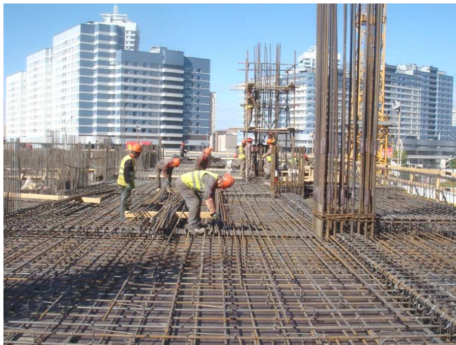
Рисунок 4. – Поэлементный монтаж арматурного каркаса колонны
