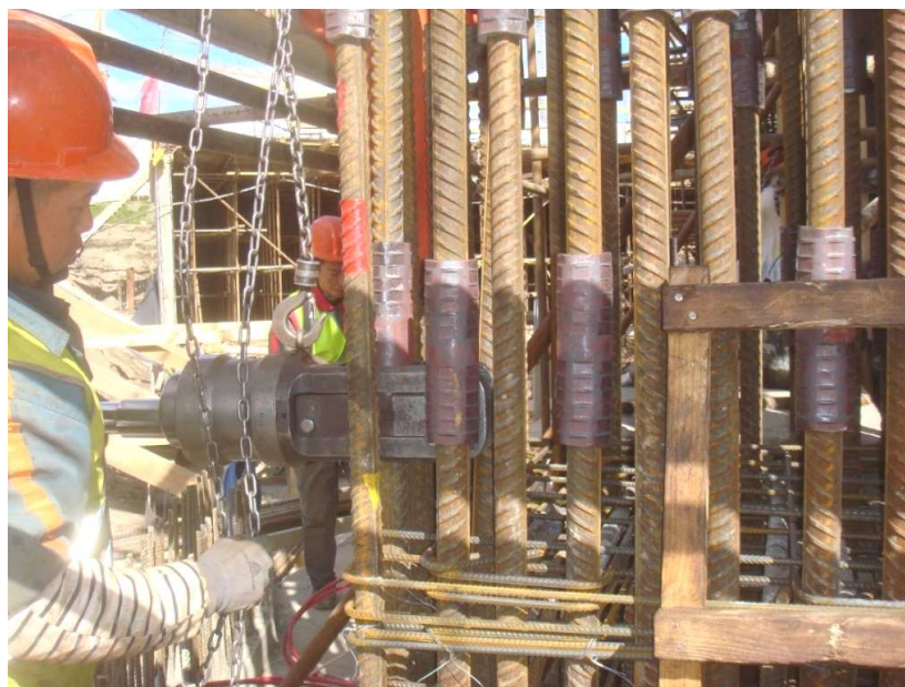
Рисунок 3. – Обжатие соединительной муфты на втором стыкуемом стержне (существующем выпуске арматуры)
