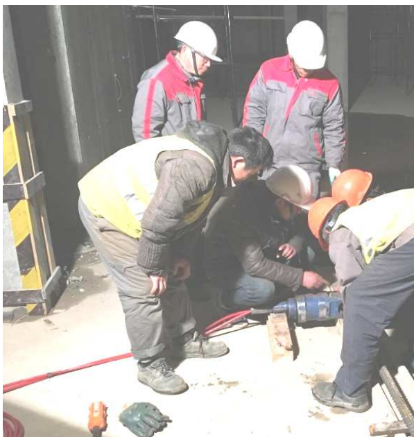
Рисунок 2. – Установка и опрессовка соединительных муфт на стыкуемом стержне
