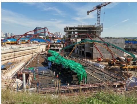
Рисунок 3. Фундаментная плита в процессе бетонирования
