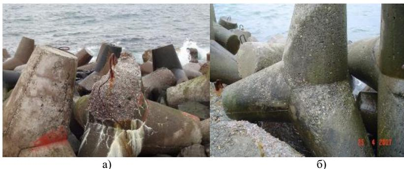
Рисунок 1. Виды разрушения бетона в тетраподах после 45 лет эксплуатации: а – объемное разрушение; б – поверхностное разрушение в виде шелушения
