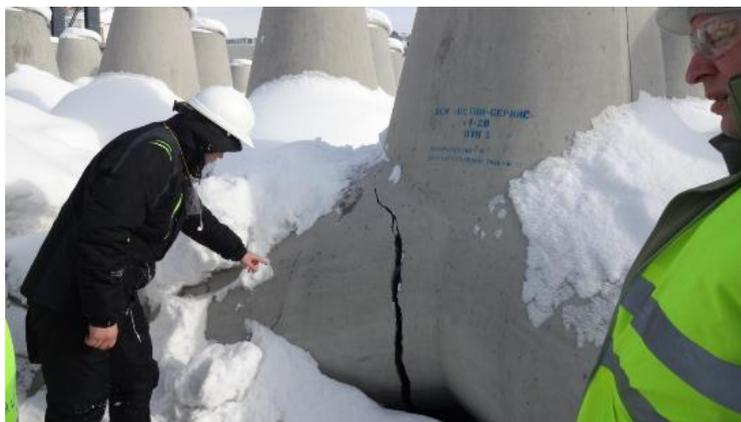
Рисунок 8. Вид разрушения  $P_T$  у тетраподов Т-20 на объекте ХЗ-3: раскрытие трещин в бетоне и последующая фрагментация
