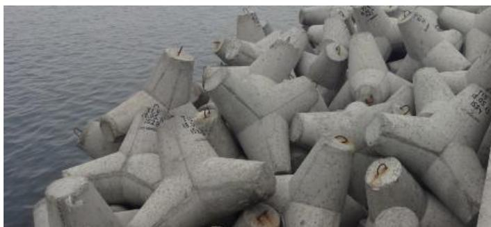
Рисунок 7. Точечное поверхностное разрушение бетона после первого зимнего сезона на объекте K3-2
