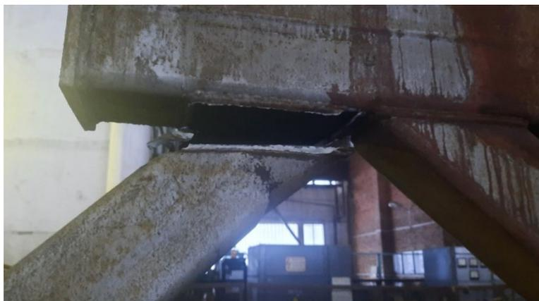
Рисунок 5. Разрушение по сварному шву опорного раскоса подстропильной фермы в зоне примыкания к нижнему поясу
