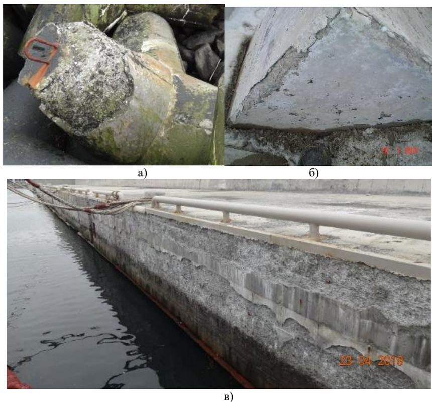
Рисунок 2. Вид разрушения  $P_C$  – отслоение поверхностной части бетона с последующим объемным разрушением внутренних слоев бетона:
