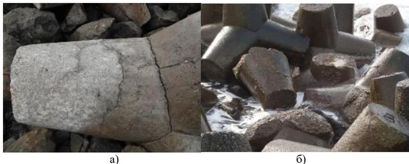
Рисунок 3. Вид разрушения  $P_T$  у тетраподов на объекте X2-1:
