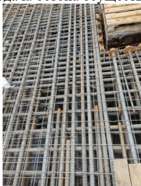
Рисунок 2. Пример армирования фундаментной плиты
