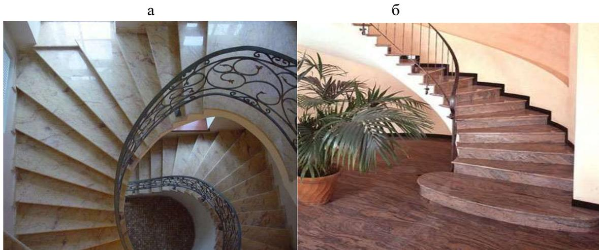
Рис.7.17. Лестницы с применением натуральных камней: а – винтовая из мрамора; б – с поворотом из гранита.
