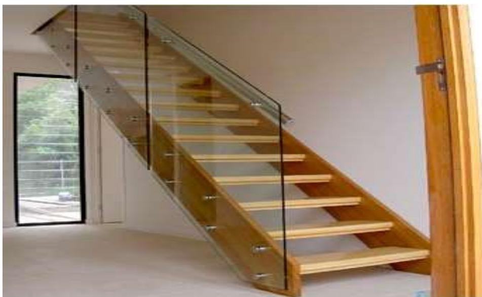
Рис.7.10. Деревянная лестница со стеклянными перилами.
