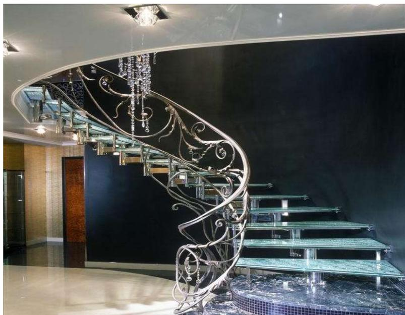
Рис.7.12. Стеклоянная лестница с перилами из кованного металла.
