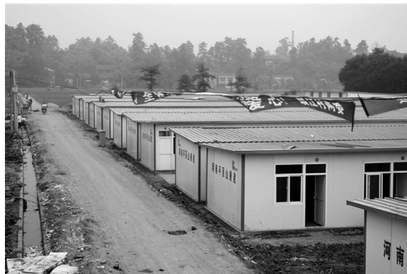
Рис. 2. Полносборные здания временного лагеря для размещения пострадавших при ликвидации последствий землетрясения 2008 г. в городе Меньян провинции Сычуань
