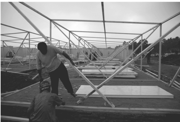
Рис. 3. Монтаж каркаса временного сборного здания
