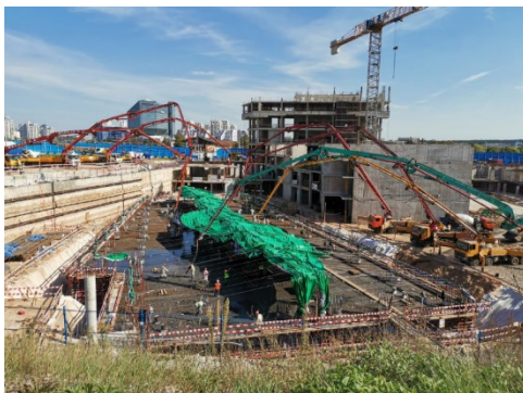
Рисунок 3. Фундаментная плита в процессе бетонирования
