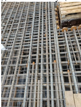
Рисунок 2. Пример армирования фундаментной плиты
