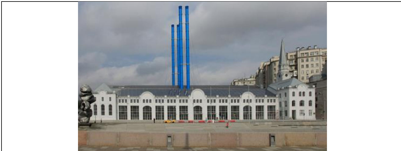
Рис.4. Центр современной культуры фонда V-A-C в бывшей электростанции ГЭС-2
