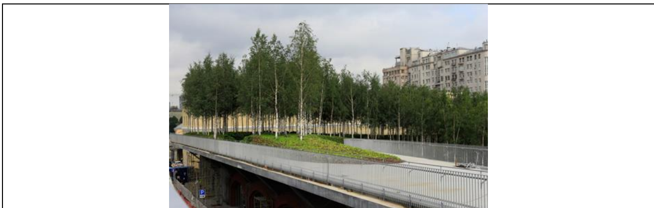
Рис.10. Центр современной культуры фонда V-A-C в бывшей электростанции ГЭС-2
