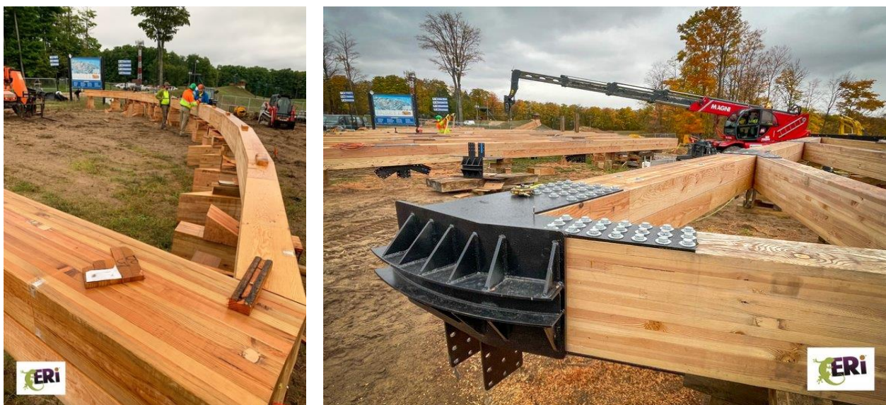
Рисунок 1 – Сборка ферм
