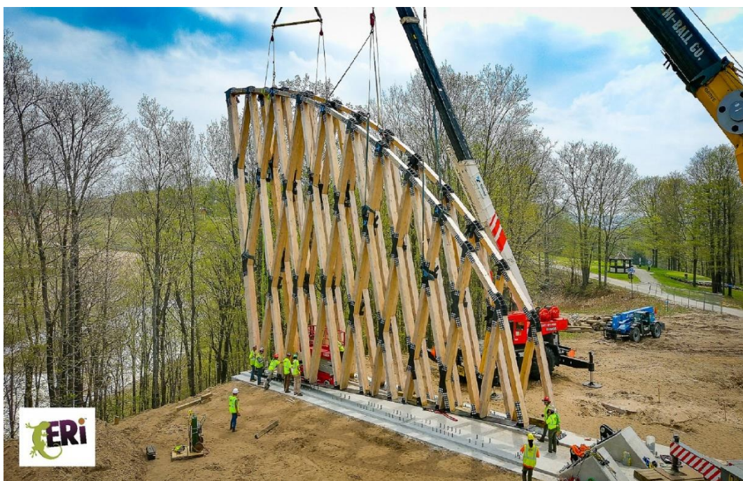
Рисунок 2 – Сборка ферм
