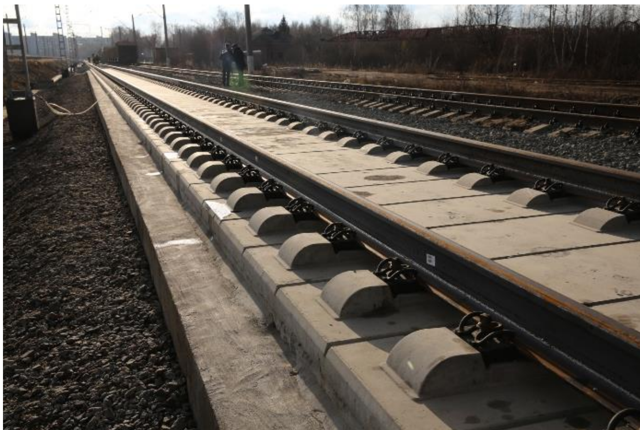
Рисунок 1 – Безбалластное основание
