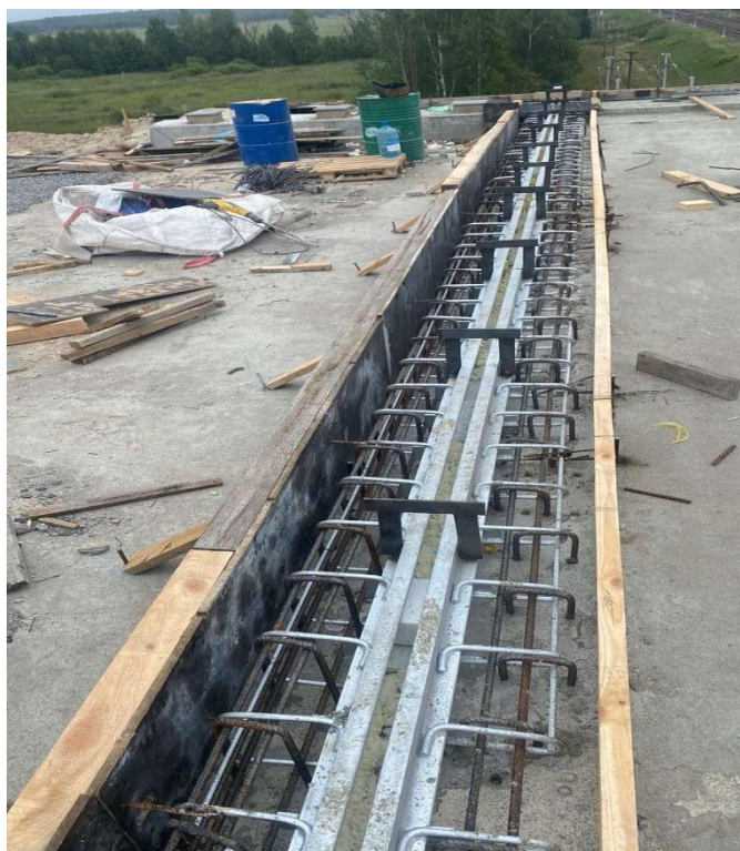
Рисунок 1 – Деформационный шов типа Маурер
