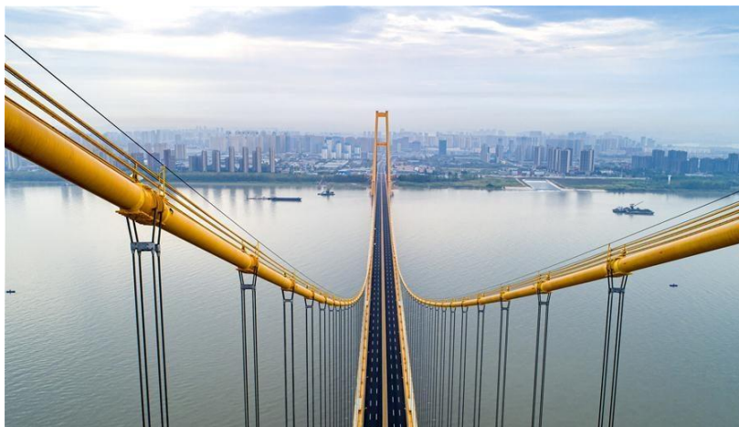
Рисунок 2 – Вид с пилона мост Янсыган
