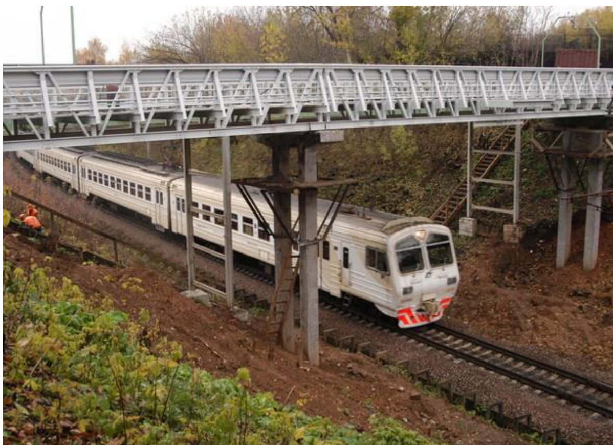
Рисунок 1 – Общий вид сооружения
