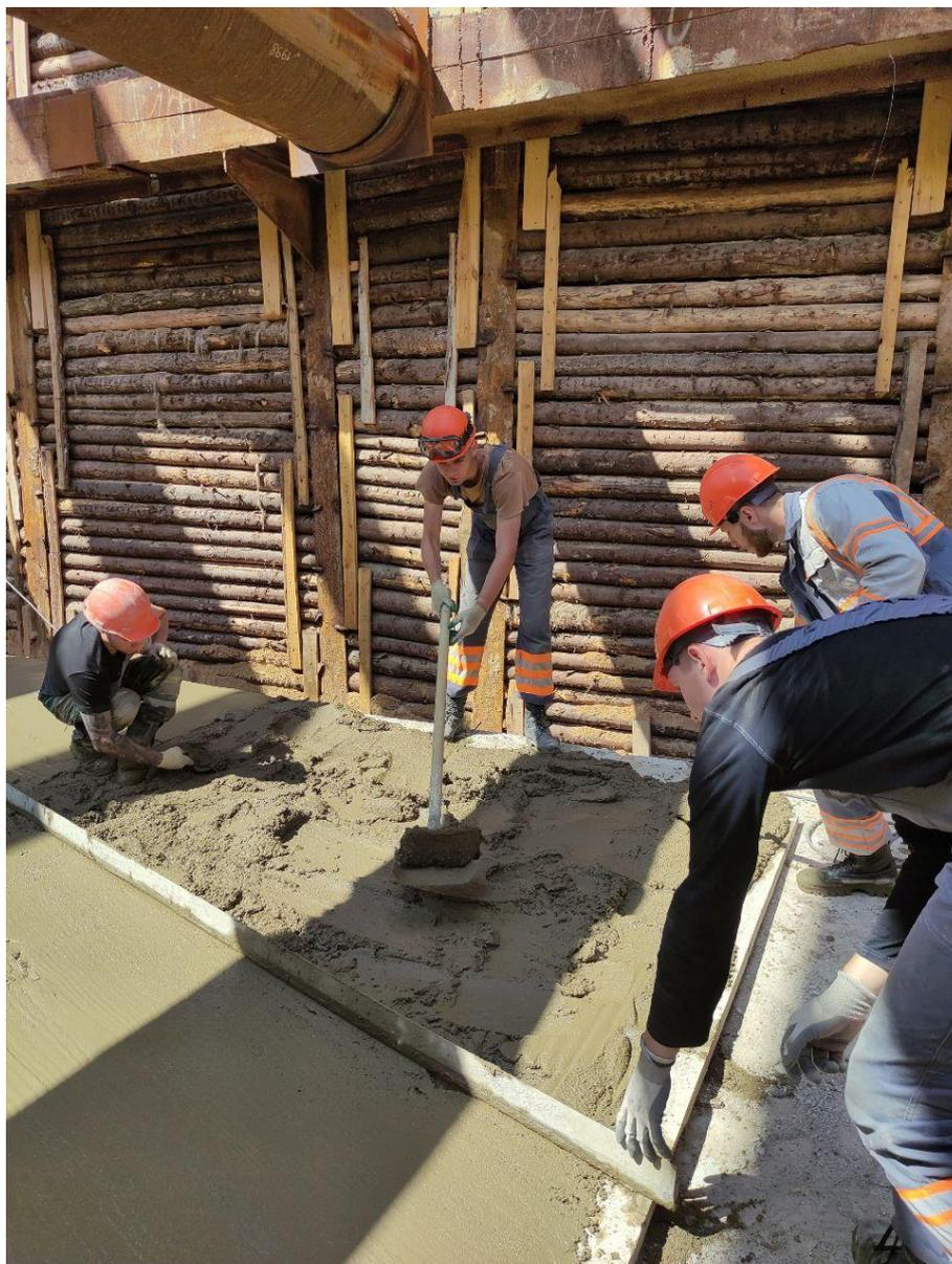
Рисунок 2 – Устройство стяжки
