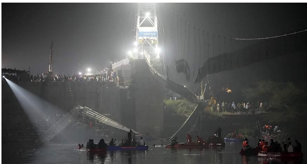
Рисунок 1 – Мост через реку Мачху после разрушения
