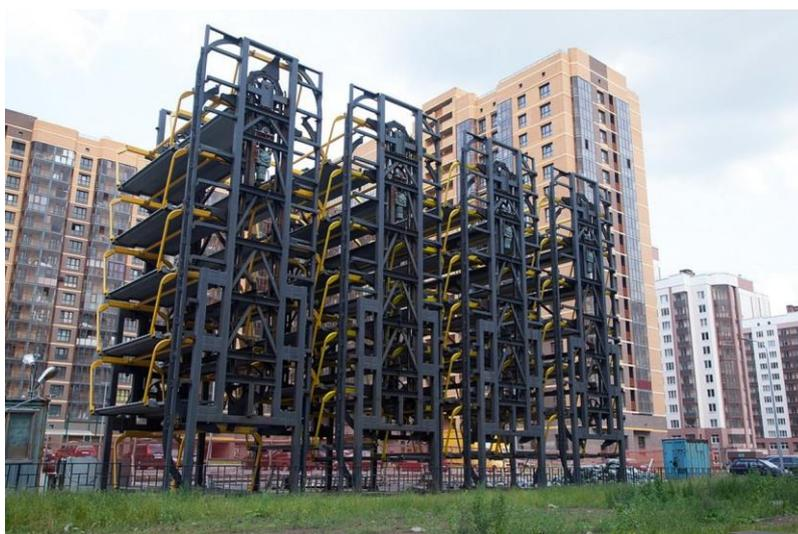
Рисунок 5 – Роторная механизированная парковка
