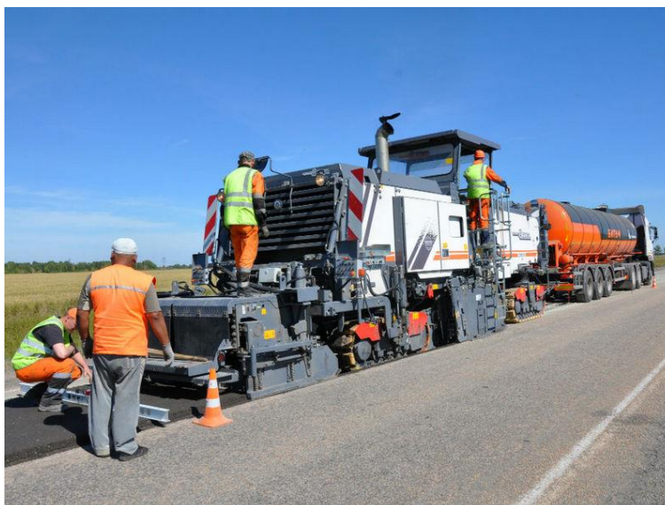
Рисунок 1 – Машина для холодного ресайклинга
