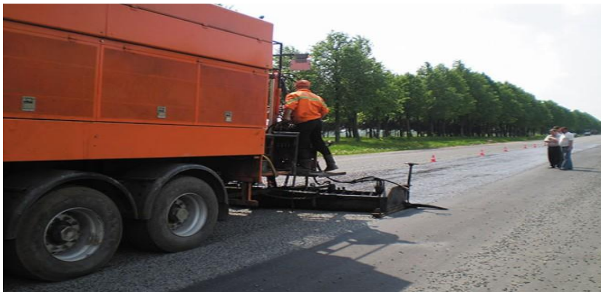
Рис. 1 Устройство защитного слоя из холодных литых асфальтобетонных смесей с противогололедными материалами пролонгированного действия
