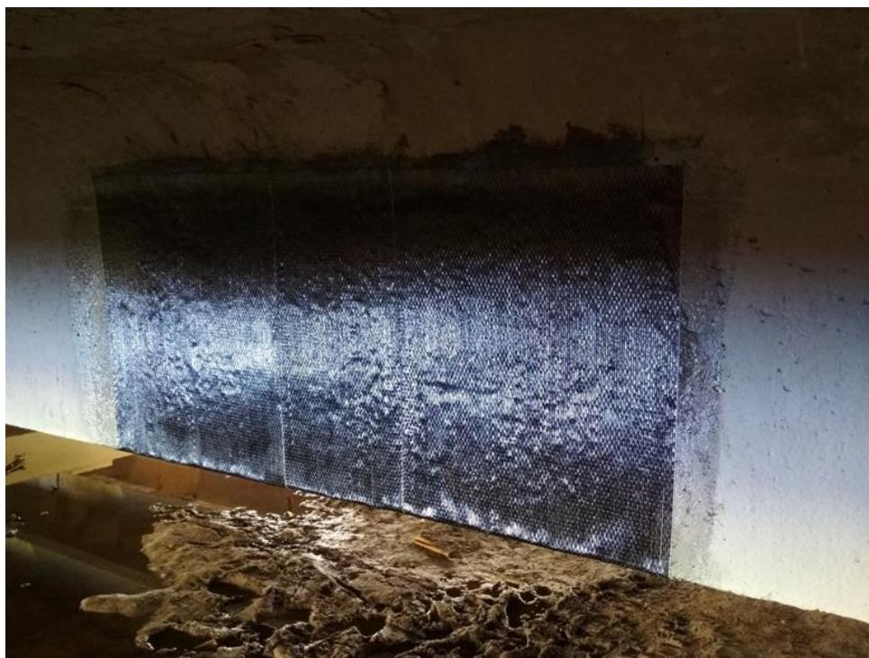
Рис. 6. Локальное армирование балки моста
