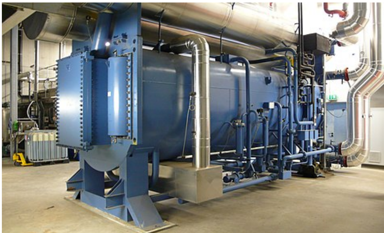
Рисунок 3 – Абсорбционная холодильная машина
