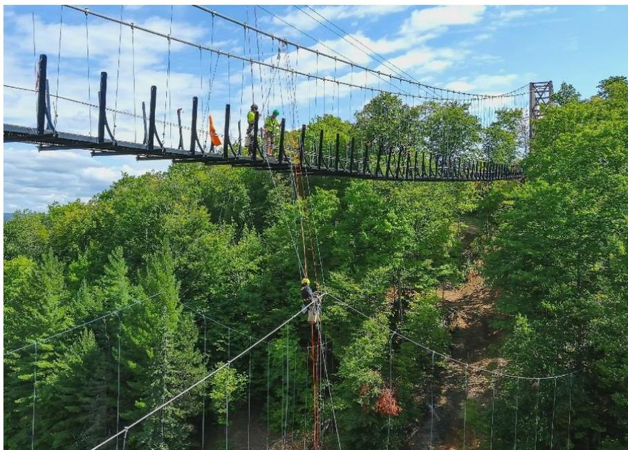
Рисунок 3 – Монтаж канатов ветряных растяжек
