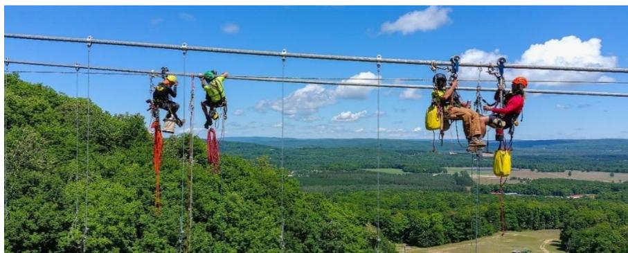
Рисунок 2 – Монтаж подвесок
