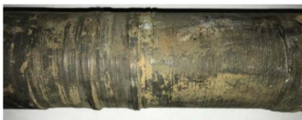
Рисунок 2 – износ втулки вала гидростатического подшипника в среде ТЖМТ
