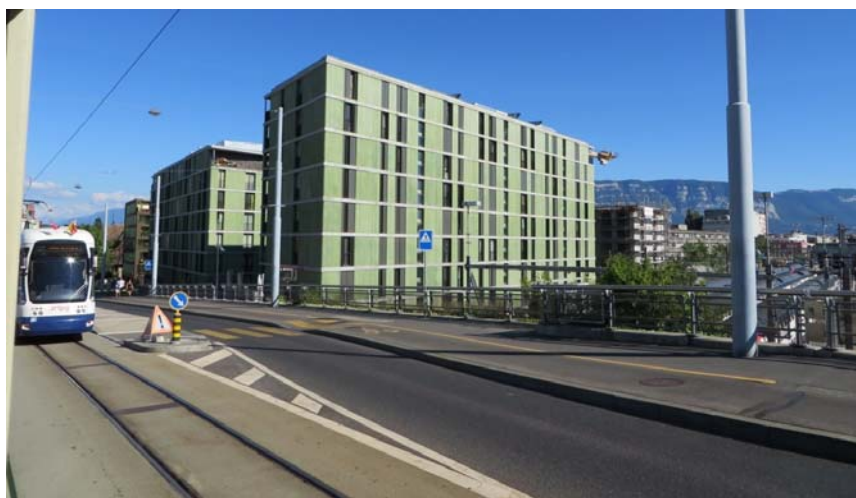
Рис. 2.31. Устройство остановочного пункта трамвая на путепроводе через железнодорожные пути в г. Женеве 2
