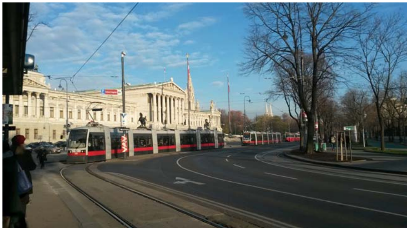
Рис. 2.26. Трамвайный путь, расположенный по краю проезжей части в г. Вене 2
