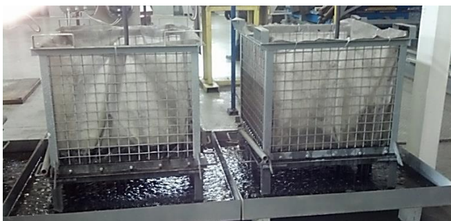
Рис. 4. Шламовые корзины фильтрации раствора на ООО «Осколнефтемаш»
