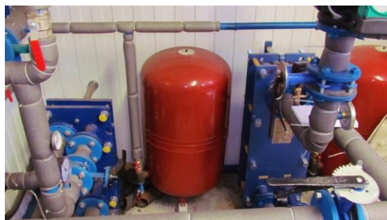
Рисунок 3.5 – Бак-аккумулятор
