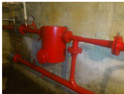
Рисунок 3.6 – Схема элеваторного ввода системы отопления:
