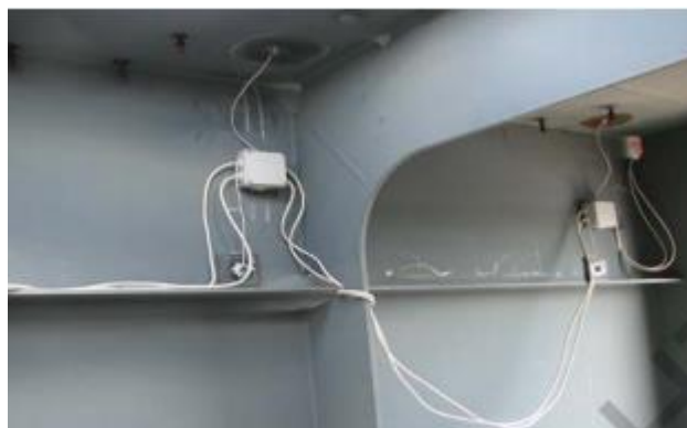
Рисунок 6.6 – Вид установки тензодатчиков на конструкции моста
