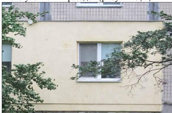
Рисунок 4. Участок стены эксплуатирующегося в течение 40 лет панельного дома (наружные стены из керамзитобетона и шлакобетона, облицованного керамической плиткой), утепленный пенополистирольными плитами
