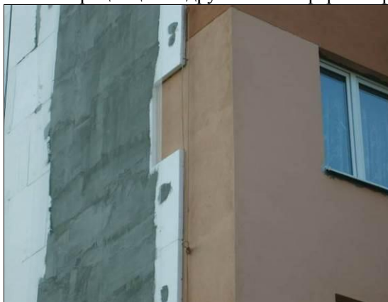
Рисунок 3. Фрагмент фасада эксплуатирующегося нового дома со стенами из АГБ в процессе облицовки плитами из пенополистирола (кладка из стеновых блоков из АГБ под первым штукатурным покрытием)
