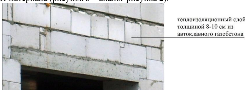
Рисунок 5. Фрагмент фасада строящегося дома со стенами из АГБ, утепленного в уровне перекрытия плитами из АГБ (консольный выступ – 8-10 см; железобетонные переемы выполнены из тяжелого цементного бетона)
