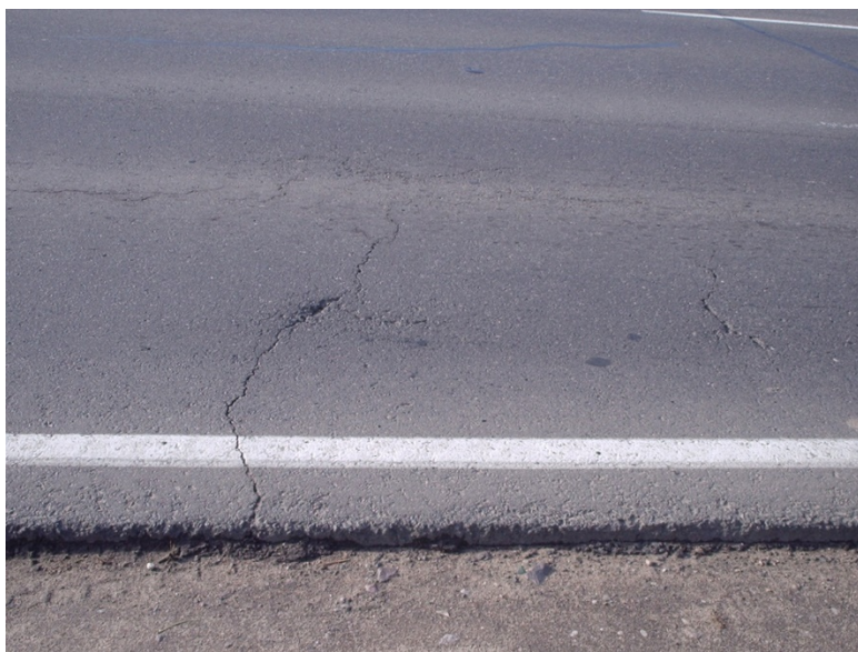
Рис. 1.1. Поперечное трещинообразование усталостного характера
