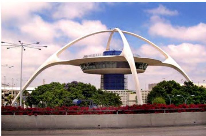
Рис. 2.17. Здание Центра управления полетами в районе аэропорта
