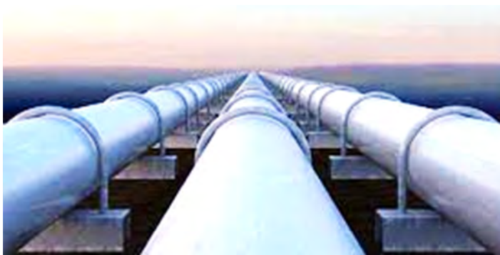
Рис. 2.20. Вид магистрального трубопровода
