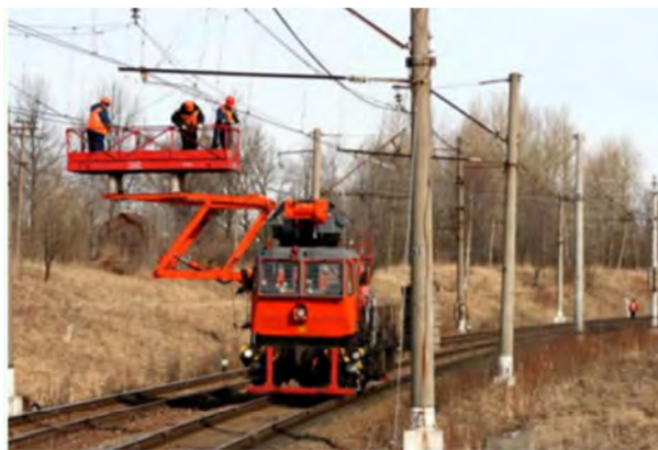
Рис. 2.8. Выполнение работ по ремонту контактной сети
