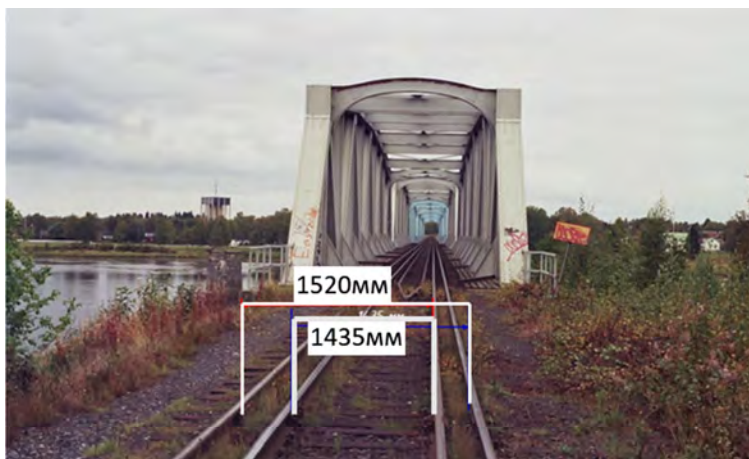
Рис. 2.5. Совмещенная колея на границе Швеции и Финляндии: широкая (1520 мм) и узкая (1435 мм)
