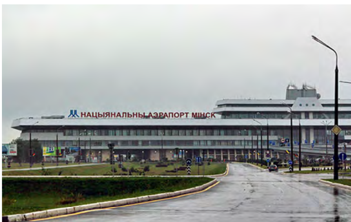
Рис. 2.18. Здание аэровокзала в Минске
