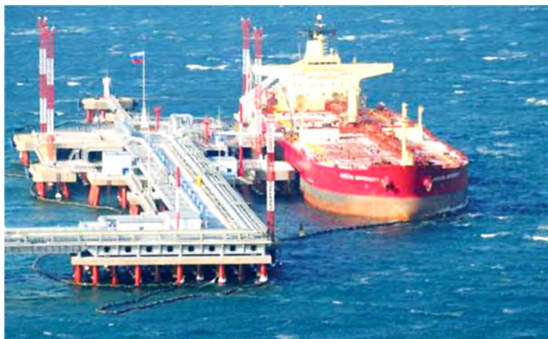
Рис. 2.24. Вид принимающей станции нефтепровода
