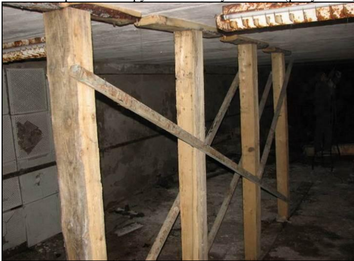
Рисунок 2. Конструкция временного усиления плит перекрытия
