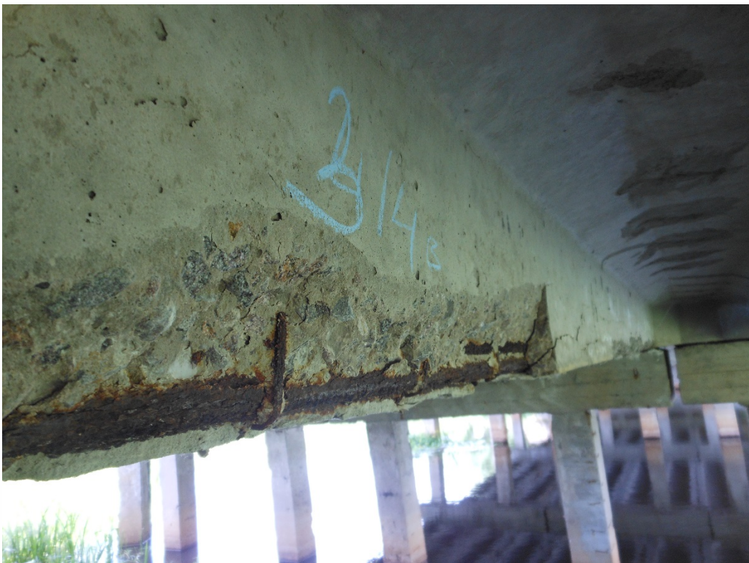
Рисунок 9.1: а), б), в) коррозия стальной арматуры (фото автора)
