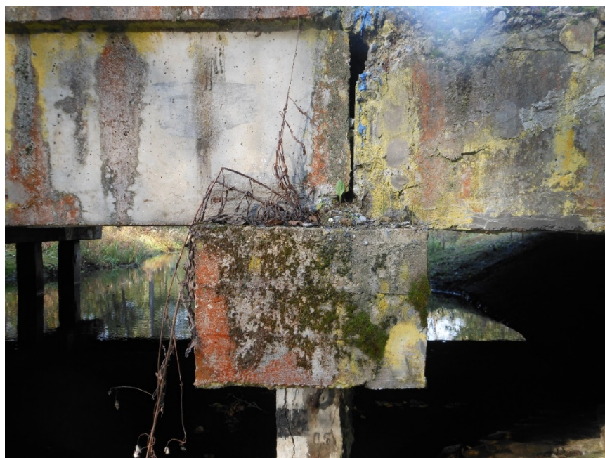
Рисунок 4.3. Эксцентриситет опирания. Изменение расчетной схемы (фото автора)
