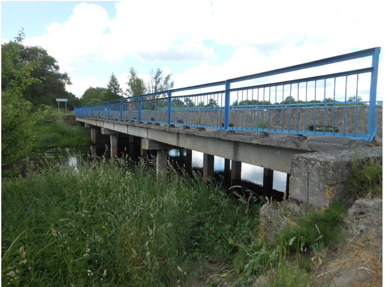
Рисунок 1.1. Мост через реку (фото автора)
