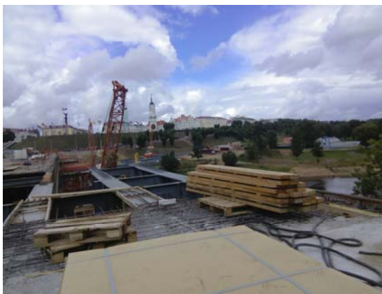
Рис. 30.2. Складирование пиломатериала на пролетном строении
