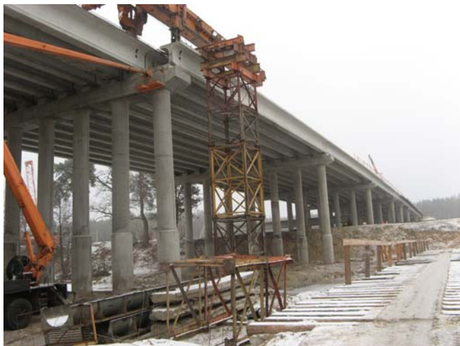
Рис. 6.1. Временная опора для крана КШМ из инвентарных конструкций
