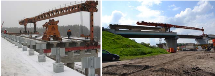
Рис. 19.1. Монтаж балок пролетного строения краном КШМ-63
