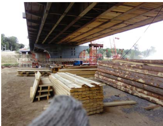
Рис. 30.1. Складирование пиломатериалов на строительной площадке
