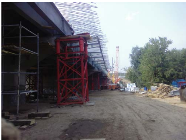
Рис. 26.1. Монтаж сталежелезобетонного пролетного строения
