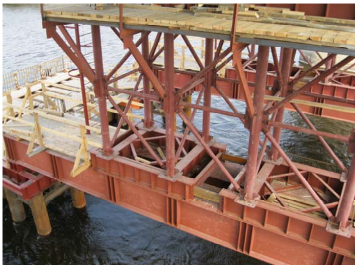
Рис. 6.3. Конструкция временной опоры для выдомкрачивания пролетного строения
