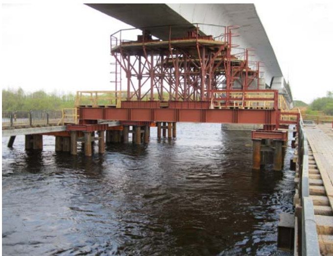
Рис. 6.5. Временный мост и опора на строительной площадке
