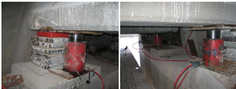
Рис. 29.1. Устройства для подъема и опускания балок пролетного строения
