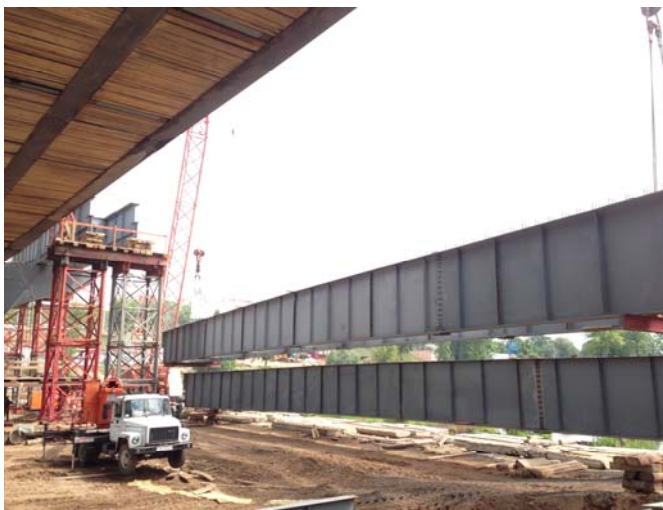
Рис. 6.2. Временная опора из инвентарных конструкций
