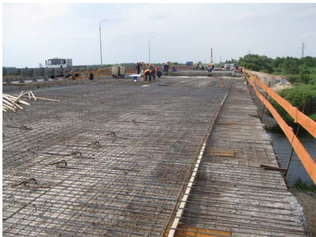
Рис. 30.4. Рабочая зона на пролетном строении
