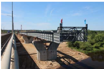
Рис. 21.1. Движка пролетного строения. Аванбек
