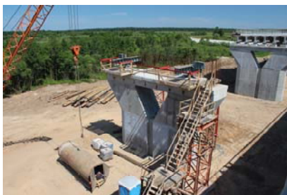
Рис. 21.2. Обстройка опоры при движжке
