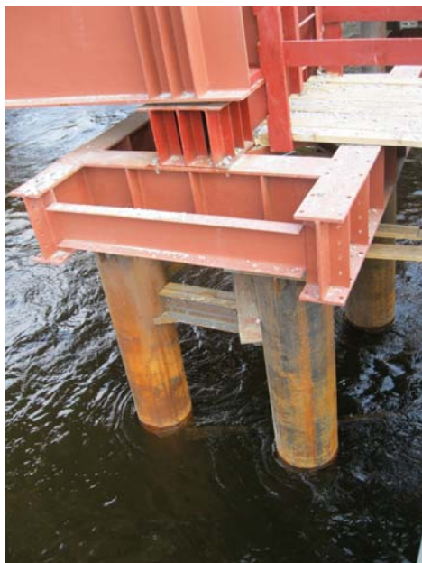
Рис. 6.6. Основание временной опоры из стальных труб
