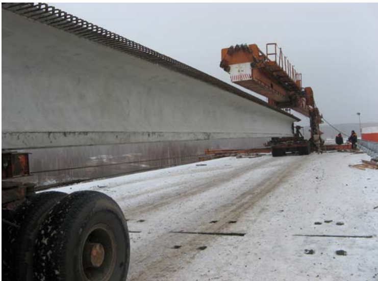
Рис. 19.2. Подача и строповка балки монтируемого пролетного строения со смонтированного пролетного строения
