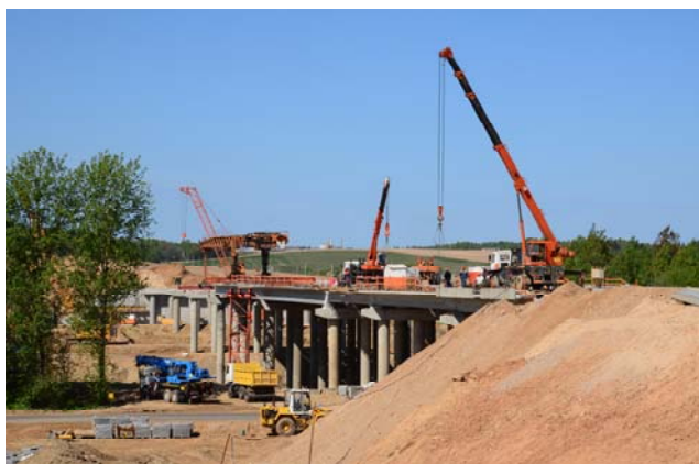
Рис. 17.1. Монтаж балок пролетных строений
