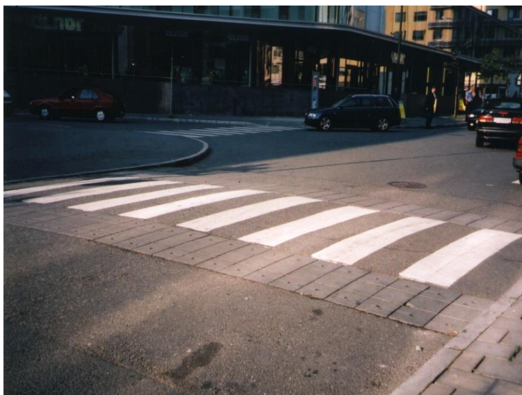
Рис. 3.21. Пример устройства искусственной неровности (г. Минск)
