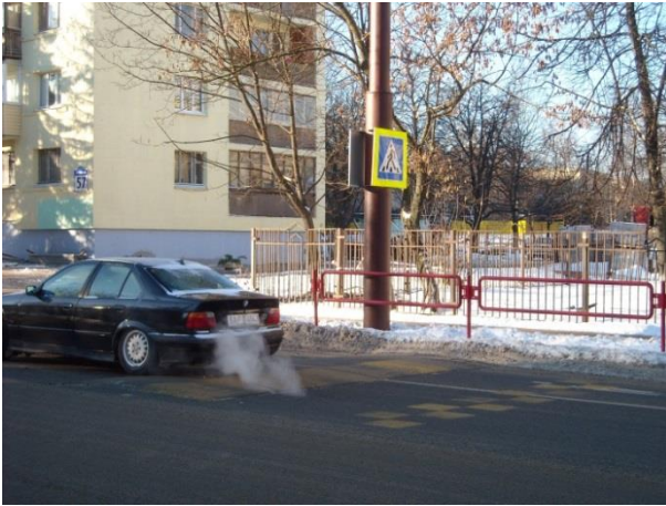
Рис. 3.22. Искусственная неровность на подходе к пешеходному переходу по ул. Куйбышева, д. 57, г. Минск
