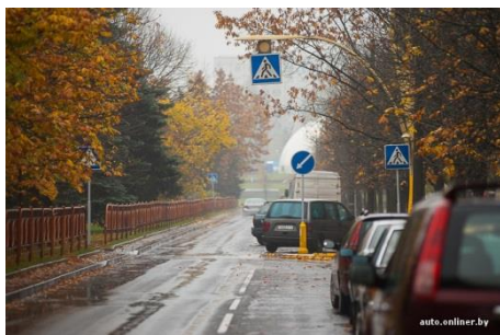
Рис. 3.13. Устройство сужения в зоне нерегулируемого пешеходного перехода (ул. Д. Сердича, г. Минск) с устройством сигнального светофора Т.7 и освещения перехода с электропитанием на светодиодных батареях
