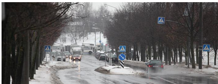
Рис. 3.15. Устройство зигзага островком безопасности и сужением проезжей части с помощью резервных полос для стоянок транспорта (ул. Некрасова, д. 122, г. Минск)
