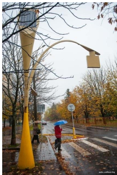
Рис. 3.13. Устройство сужения в зоне нерегулируемого пешеходного перехода (ул. Д. Сердича, г. Минск) с устройством сигнального светофора Т.7 и освещения перехода с электропитанием на светодиодных батареях
