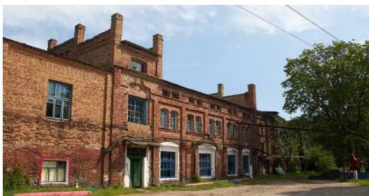
Рис. 2. Сахарный завод в д. Поречье
