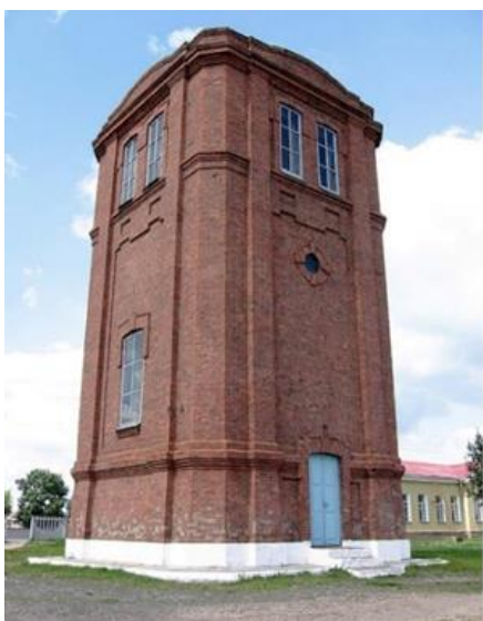
Рис. 5. Водонапорная башня в д. Старые дороги
