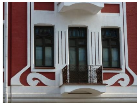
Рис. 3. Фрагмент фасада дома Оскара Яницкого [5]
