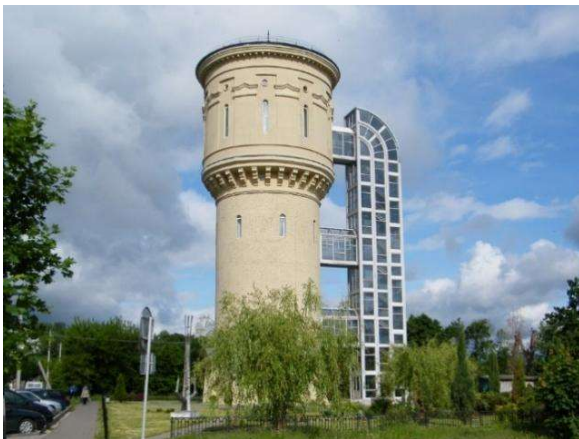
Рис. 13. Водонапорная башня в Полоцке
