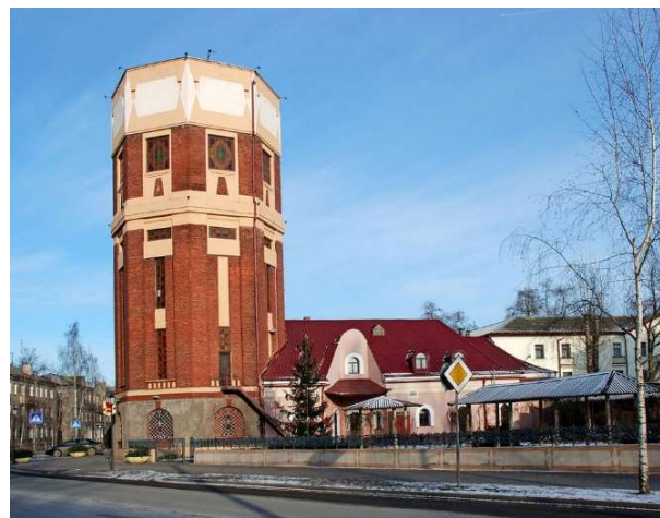
Рис. 10. Водонапорная башня в Бобруйске.
