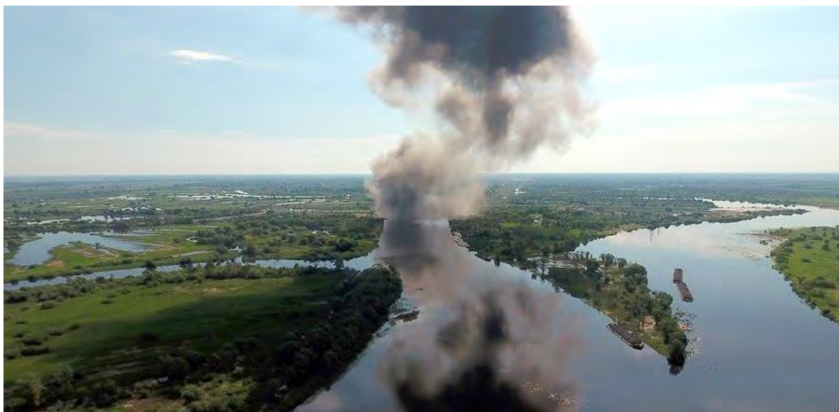
Рисунок 3 – Столб чёрной гари и пыли в небесах после подрыва пролётного строения
