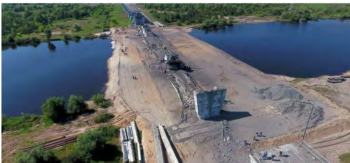
Рисунок 4 – Пролётное строение после подрыва. Начало восстановительных работ
