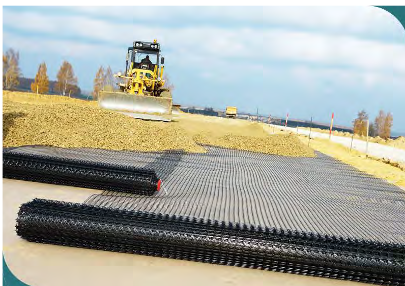
Рисунок 1 – Ремонт дорог, геосинтетические материалы для дорожного строительства
