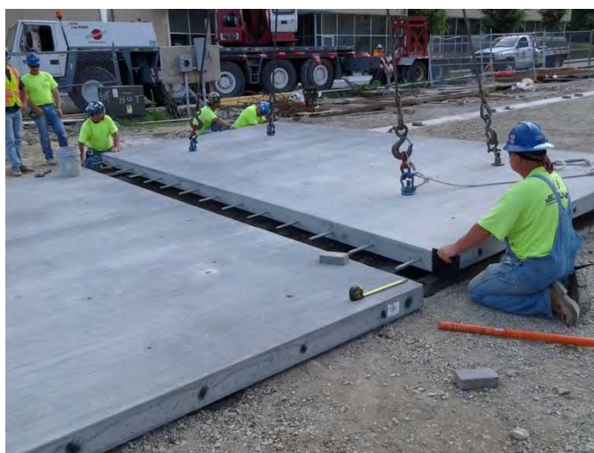
Рисунок 1 – Монтаж плиты с оптоволоконным покрытием
