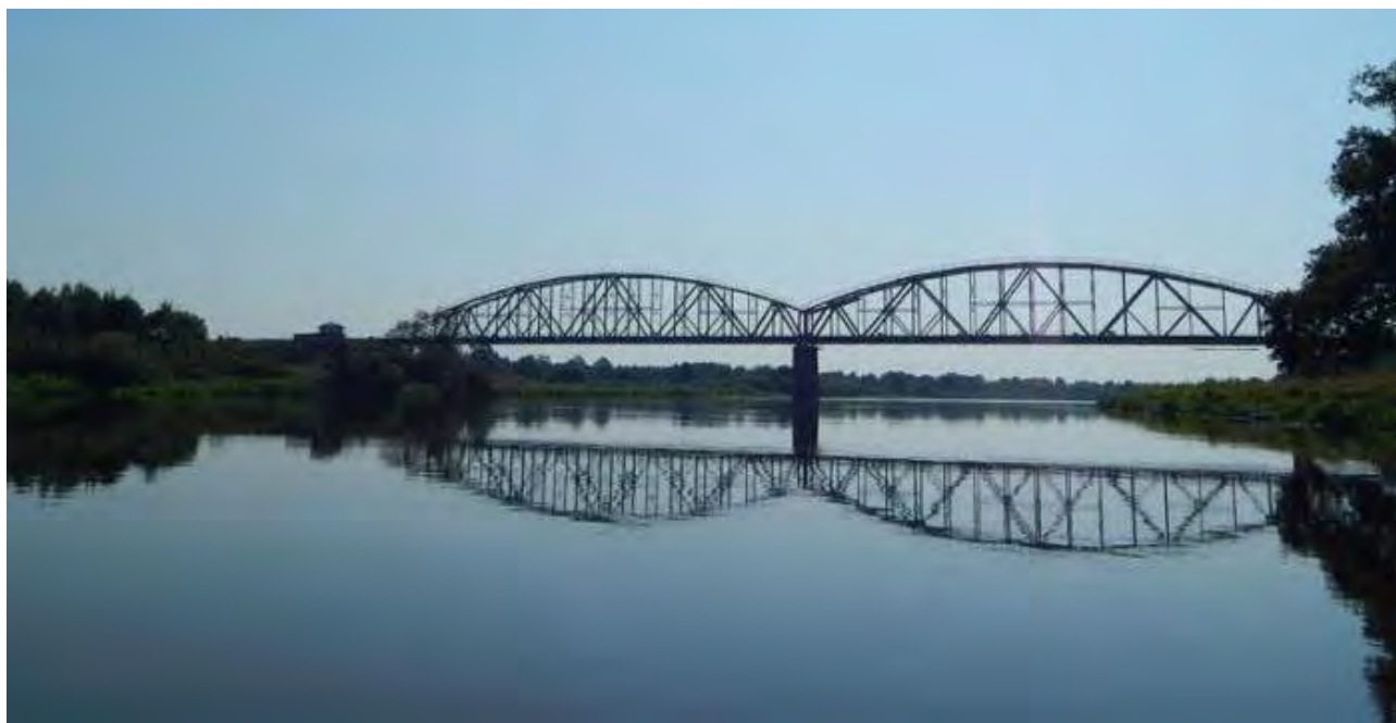
Рисунок 1 – Общий вид железнодорожного моста в Елизово со стороны русла
