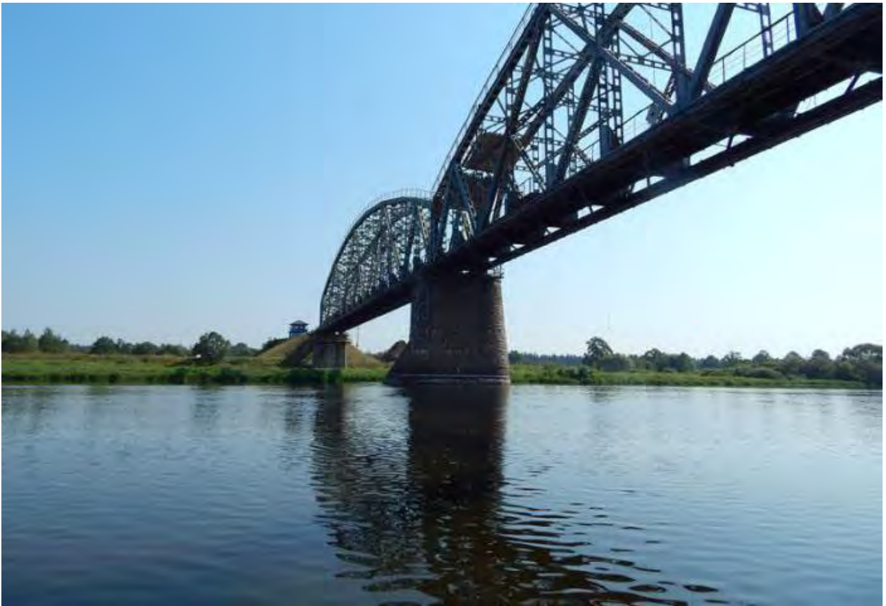
Рисунок 2 – Общий вид железнодорожного моста в Елизово с берега
