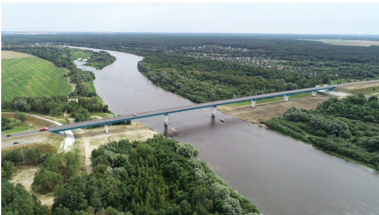
Рисунок 2 – Готовый новый мост
